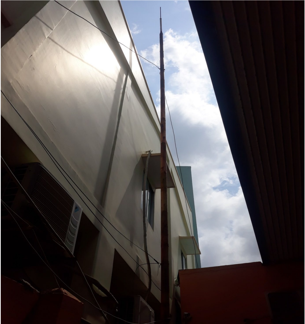
Hình 3.7. Thiết bị chống sét của cửa hàng
